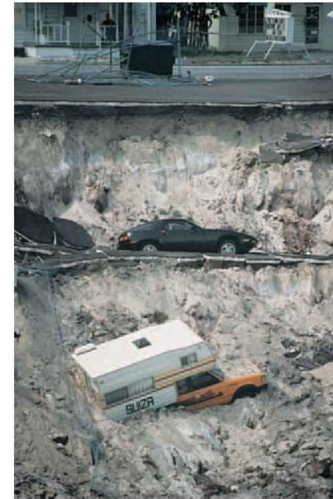
그림 3.5 플로리다의 윈터공원에 있는 패인땅. 대수층이 붕괴되면서 지반침하가 일어났다.
